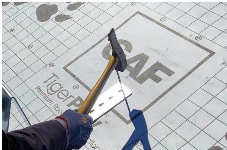
**Fig. 6. – ASEGURANDO EL SOPORTE CON CLAVOS**
